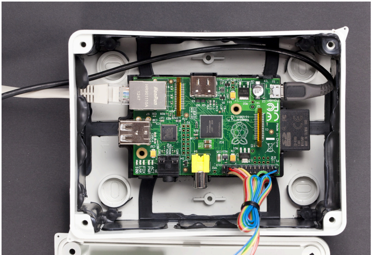
Abb. 4-17 Die angeschlossenen Kabel
