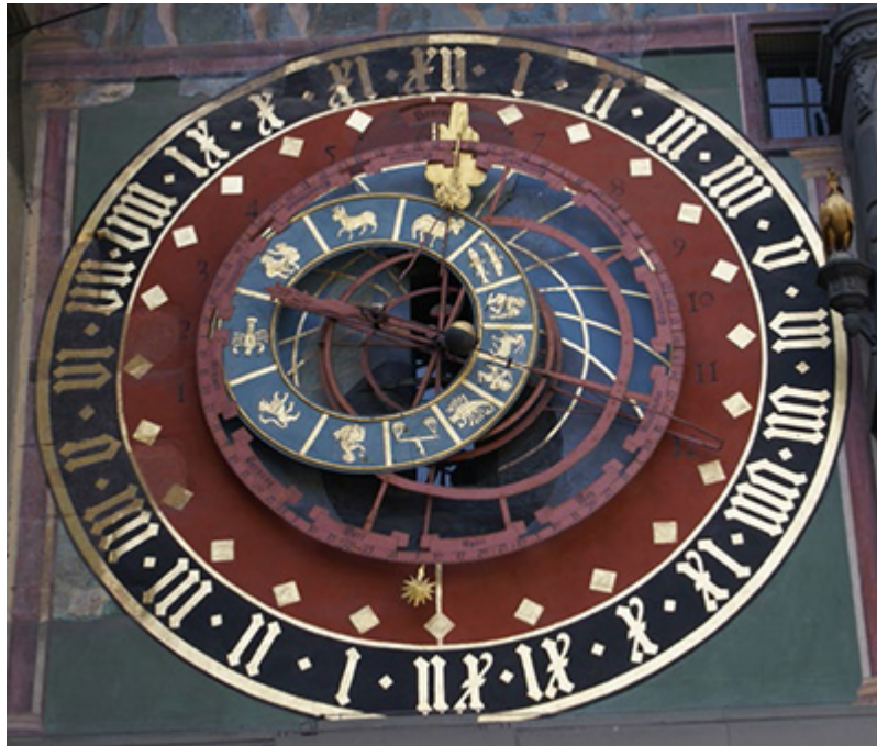
Abb. 4-5 Die Berner Zytglogge aus dem Jahr 1405 zeigt die temporalen Stunden an den goldenen Linien an und die äquinoktialen auf dem römischen Ziffernblatt.
