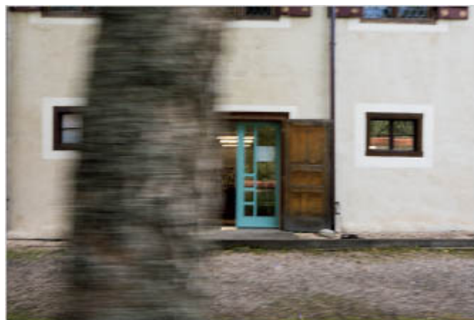
Abb. 4-23 ... desto deutlicher wird der Unterschied ...
