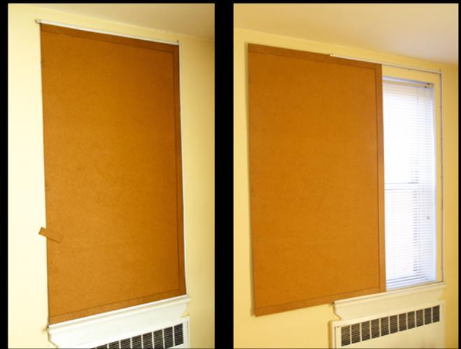
Diese abnehmbare Fensterabdeckung haben wir aus Hartfaserplatte und billigen Schienen aus dem Baumarkt gebaut.
