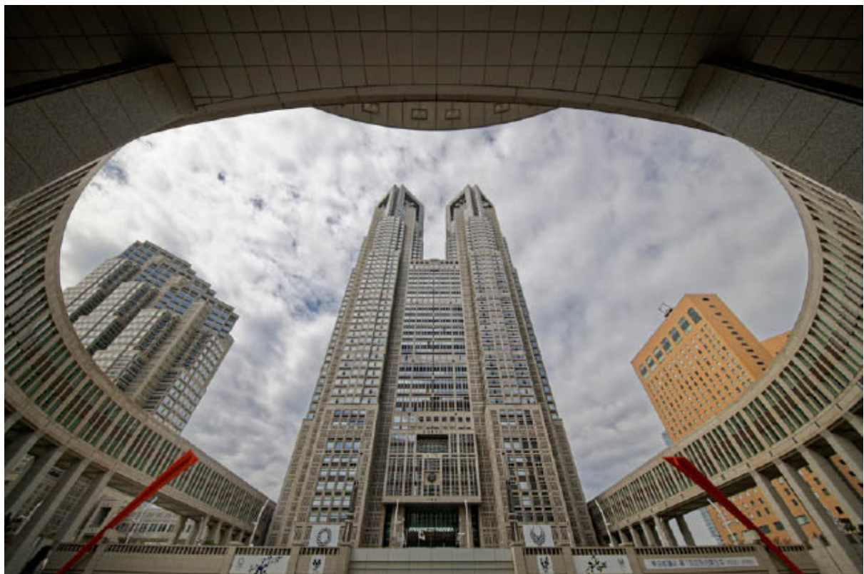
Die von dem Architekten Kenzō Tange entworfene Zentrale der Stadtverwaltung von Tokio lässt sich auch nicht aus größerem Abstand in voller Höhe ins Bild setzen. Nur mit einem 11 mm–Ultraweitwinkelobjektiv konnte ich das gesamte Gebäude fotografieren. Dazu musste ich mich
